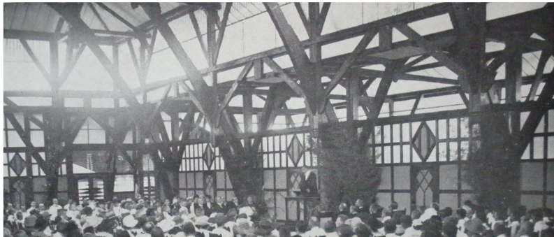
De aula van de Technische Hogeschool Bandoeng
